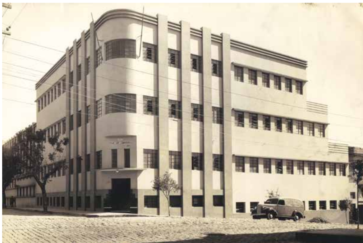
Atual prédio do Colégio Imaculada inaugurado em 1941
